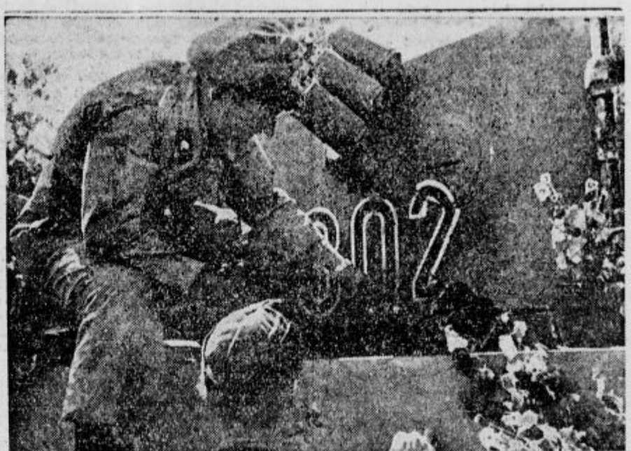
»Tiger« — leicht angekratzt. Aus 200 meter hat der »Tiger« einen Treffer erhalten, der gute Stahl des Panzers ist aber von der 15 cm-Granate nicht durchgeschlagen worden. — »Tiger« malo opraskan. Iz razdalje 200 metrov ga je zadela 15 cm granata, pa ni prebila oklepa. OK. Aufnahme, Atlantie.
