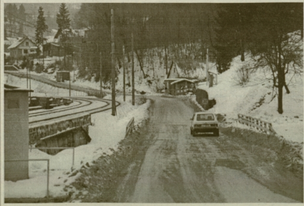
Na novih železniških propustih je treba le še položiti asfalt in narediti nove ograje.
