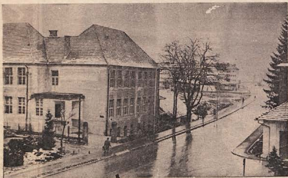
Na levi strani ceste je poslopje osnovne šole v Brežicah, iz katerega se bodo učenci jeseni preselili v novo šolo. Pod njegovo streho bodo uredili otroški vrtec. Starši že komaj čakajo, da bo mesto dobilo sodobno urejeno ustanovo za najmlajše. (Foto: Jožica Teppey)
