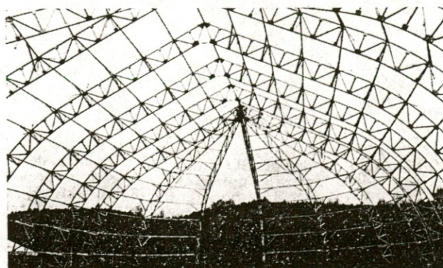
— Pogled konstrukcije šotora iz notranje strani
