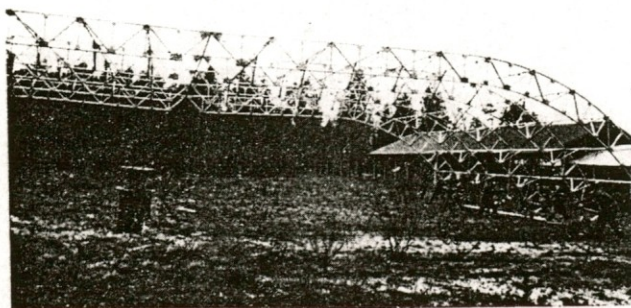
— Dviganje konstrukcije šotora s pomočjo ročnih dvigalnih naprav
