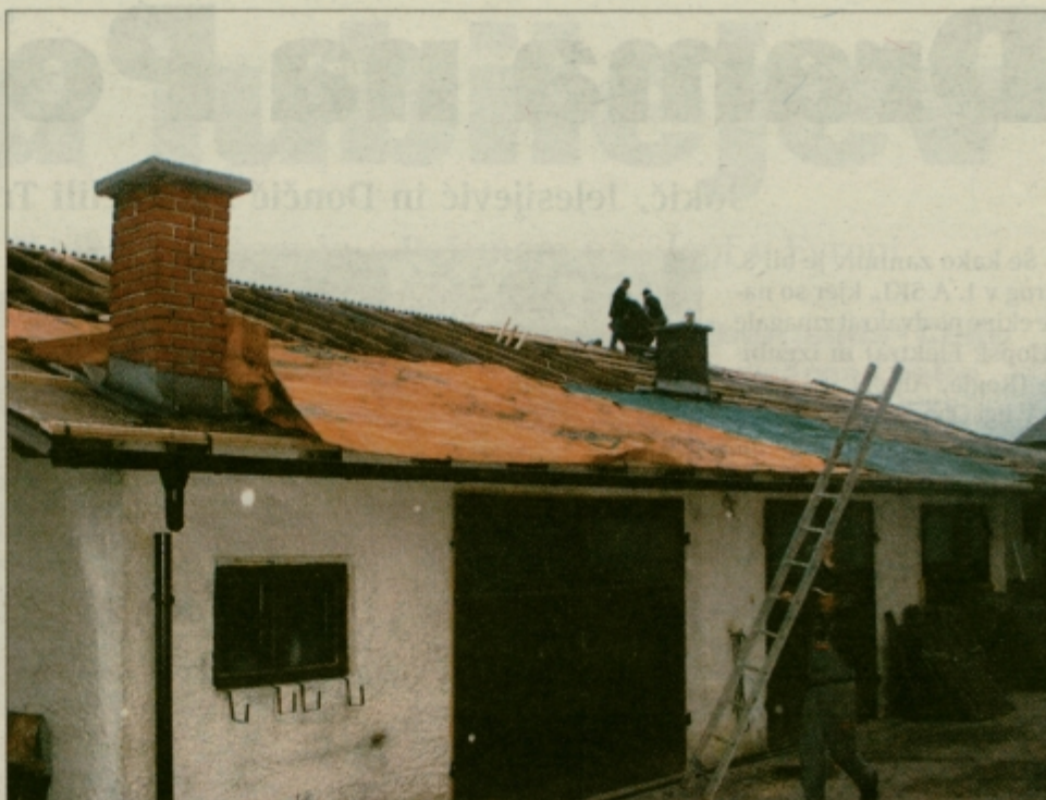
Do začetka zime bo prenova strehe na gospodarskem poslopiju Bohorčevih v celoti zaključena. Les za ostreže je iz domačega gozda, večino kritine pa so jim podarili v podjetju Ceste Mostovi Celje, kjer so pred časom prekrili eno svojih poslovnih hal.
