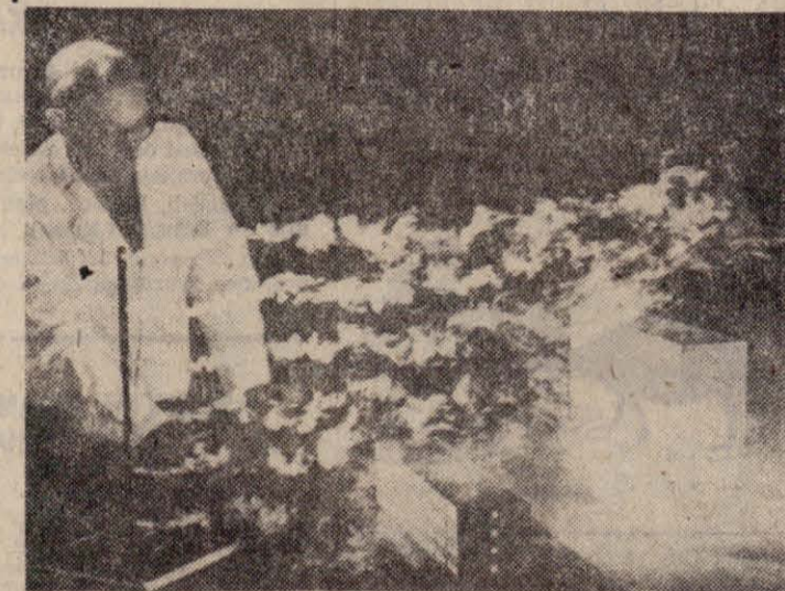
V ANGLIJI so začeli proučevati tudi vplive vremenskih sprememb, zlasti vetra na večja poslopja. Zato so morale makete nekaterih velikih hiš, ki jih bodo gradili v Angliji, v prave vetrovnike, kjer so z dimom ugotavljali, kateri deli poslopja morajo prenašati najmočnejše vetrovne udare.
