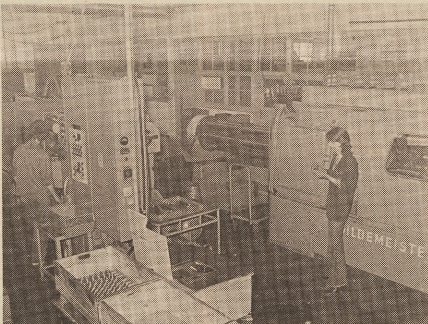
Šestvretenski avtomat za struženje zobnika, gredi in sklopke za rotacijske stroje v proizvodnji ERO.
