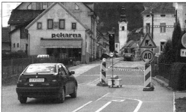
Obseg izvajanja druge gradbene faze ureditve trškega jedra zajema prostor med krožiščem na eni in zaključkom prve faze na drugi strani (foto: Benjamin Kanjir)
