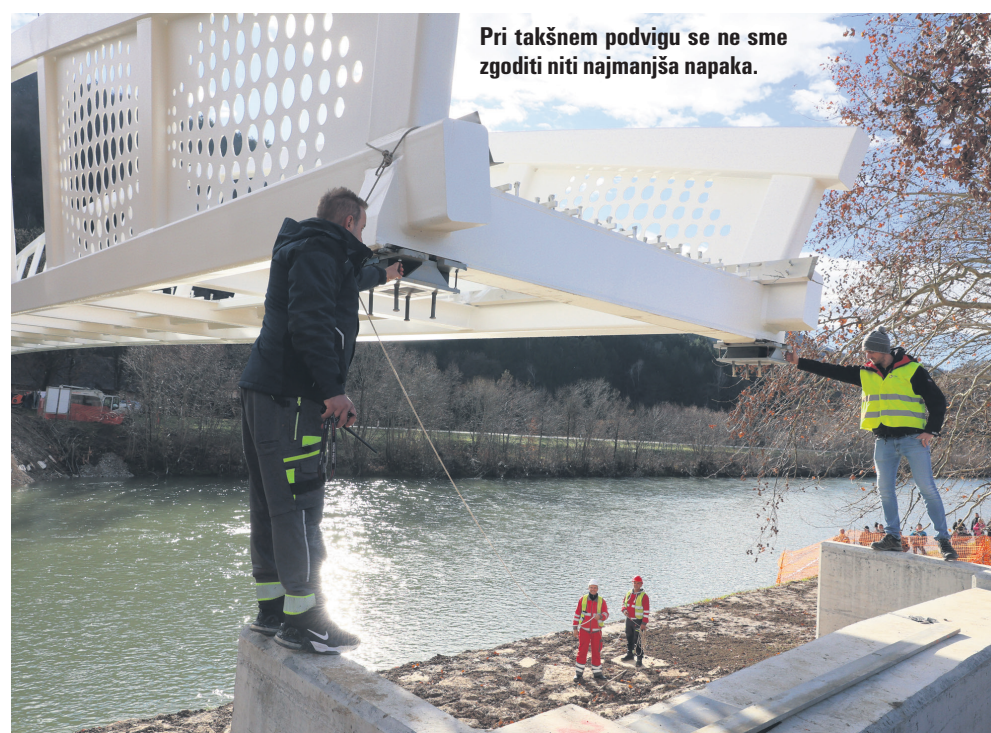
Višina »roke« žerjava, s katerim je bil most nameščen na opornike, je približno 70 metrov. Zahteven dvig, nato premik ter namestitev konstrukcije na ležišča so trajali pet ur.
