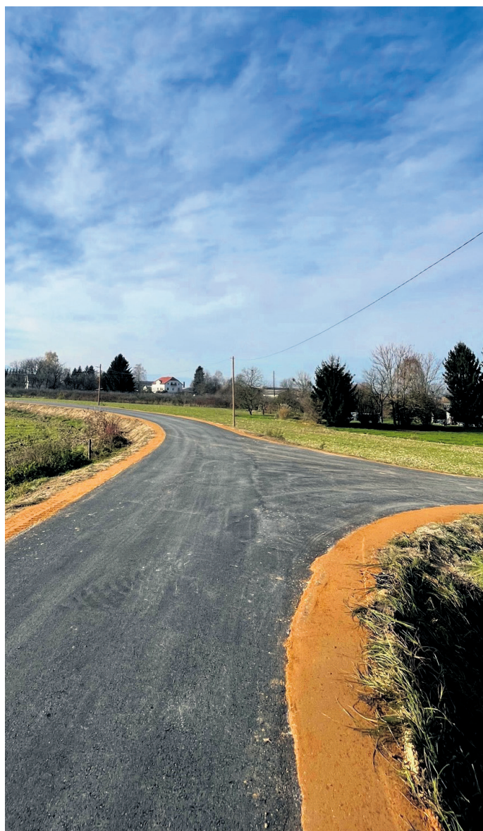
Obnovljen odsek ceste Medlog-Babno (Foto: MOC)
