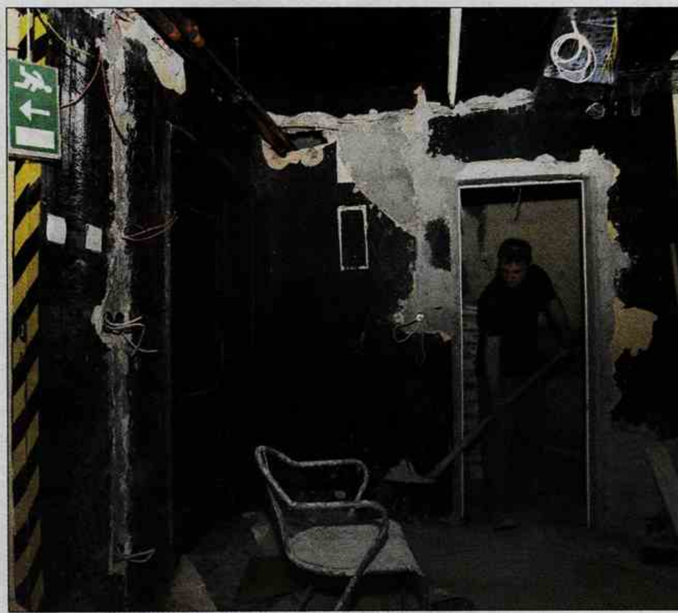
Poslovni in tehnični prostori celjskega gledališča so te dni gradbišče.
