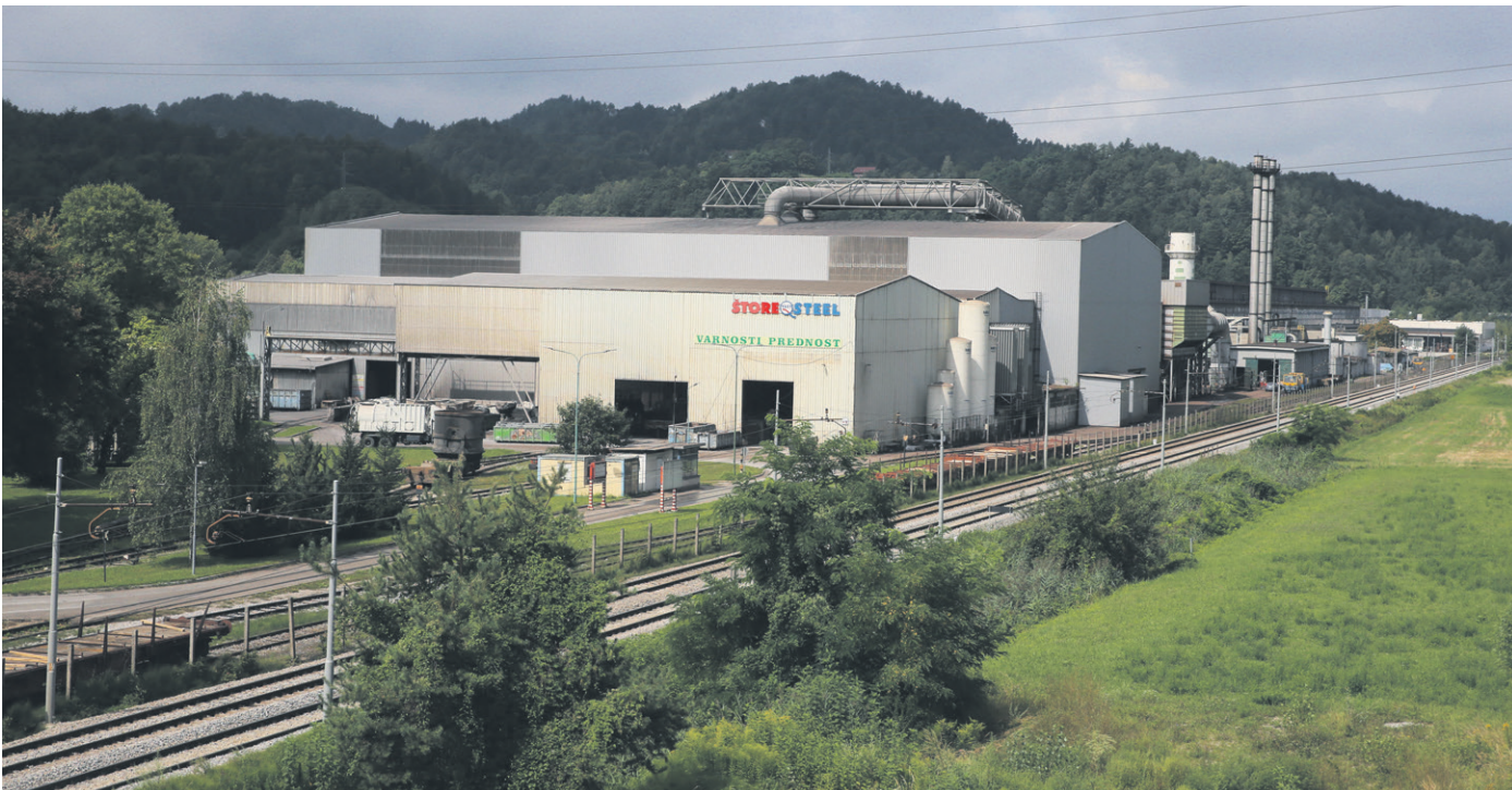
Zaradi visokih stroškov, ki jih plačuje za energente ter surovine in materiale, lanski dobiček družbe Štore Steel kljub rekordnemu obsegu prihodkov od prodaje ne bo visok. (Foto: Andraž Purg)
