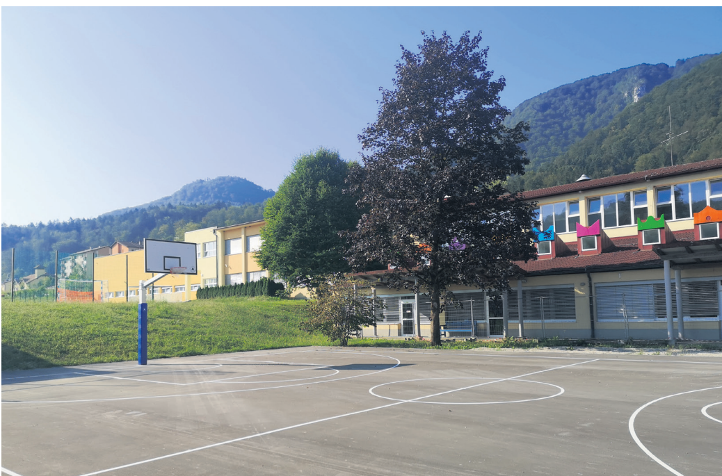
Gradnja športne dvorane v Rimskih Toplicah, ki vključuje tudi ureditev zunanjih športnih igrišč, je končana. Uporabno dovoljenje zanjo Občina Laško pričakuje v teh dneh. (Foto: BA)
