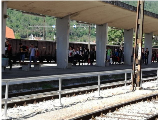
Slika 4: Prihod na železniško postajo Jesenice
