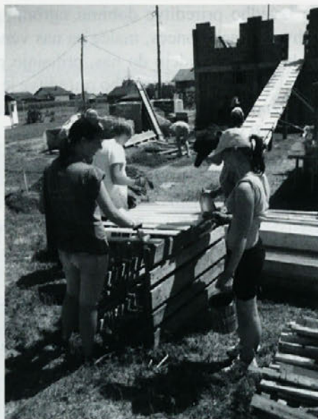
Delovišče v Novi Topoli
