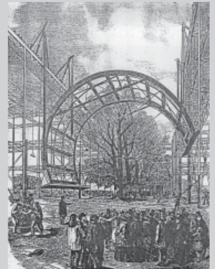
□ Slika 2. Dvigovanje vmesnega polkrožnega dela. Konstrukcija celotnega vmesnega polkrožnega dela je sestavljena iz lesa (The Illustrated London News, 1850)
