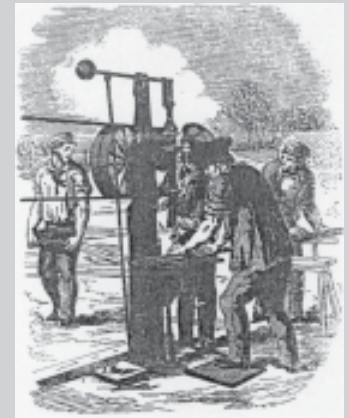
□ Slika 8. Delavci na gradbišču pripravljajo posamezne lesene sestavne dele: vrtni stroj (The Illustrated London News, 1850)
