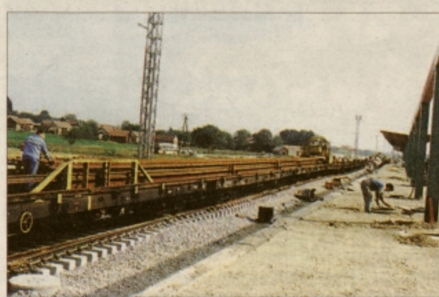
Delavci Gradisa-Gradenj Ptuj v Hodošu končujejo gradnjo 400 m dolgega perona in platoja za transport in privez živine.
