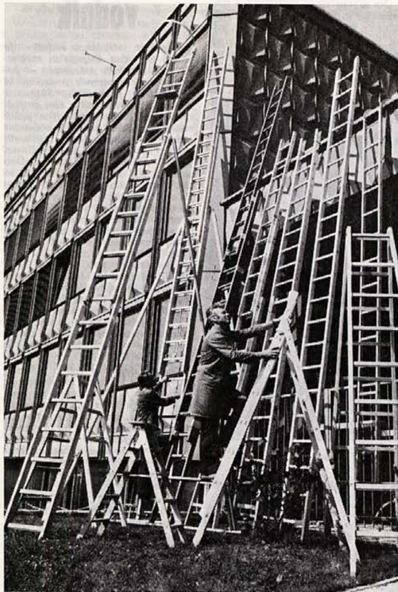
Pred odpremi se preizkus vsaka vrsta lestev — na sliki je tak preizkus na upravni stavbi
