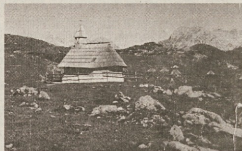
Kapelica Marije Snežne na Veliki planini, zgrajena leta 1937.
