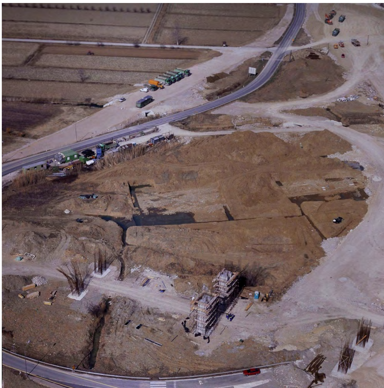
167 Izkopavanja Križišča v vozlišču različnih cest; pogled proti severozahodu (letalski posnetek, avtor Jaka Jeraša).
