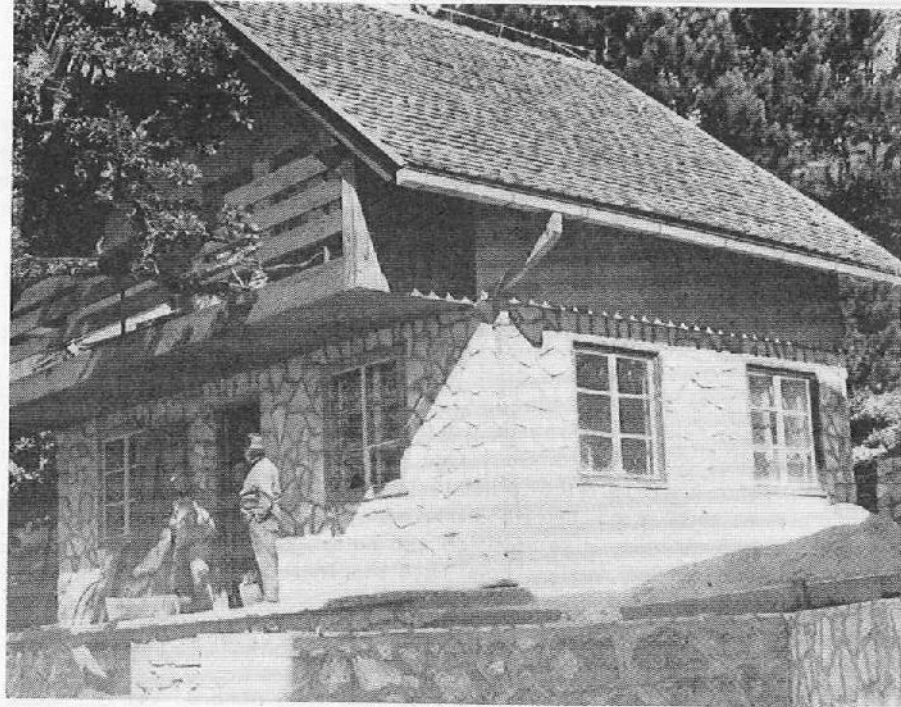
Nova Jurkova koča v gradnji, septembra 1971
