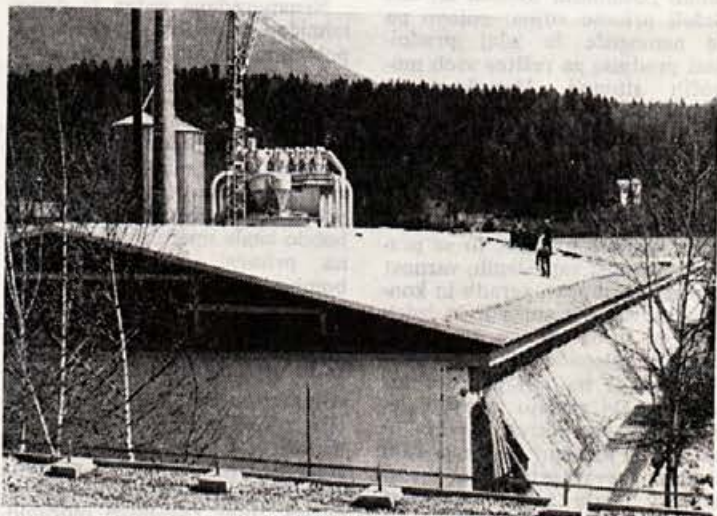
Kot smo že pisali, se je pričelo prekrivanje streh na naših proizvodnih halah. Na sliki hala A.
