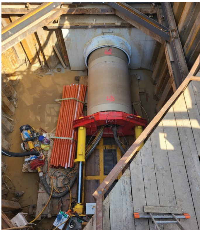
Slika 10. Potiskanje cevi med izvedbo mikrotunela.
