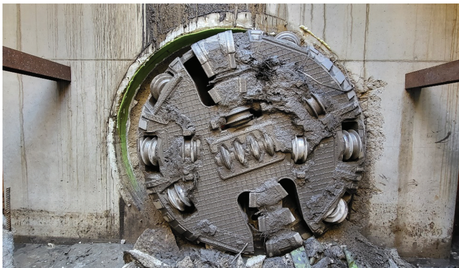
Sliki 12 in 13. Prihod vrtalne glave v izstopno gradbeno jamo in njen dvig iz gradbene jame.
