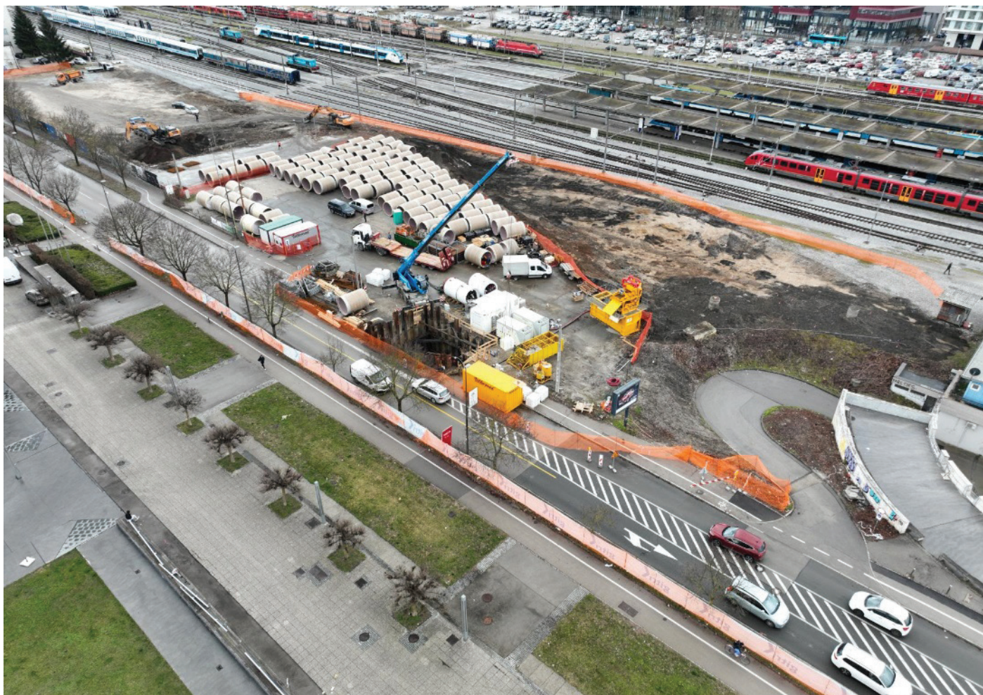
Slika 1. Pogled na gradbišče prestavitve kanalizacijskega kolektorja v času priprav na izvedbo.
