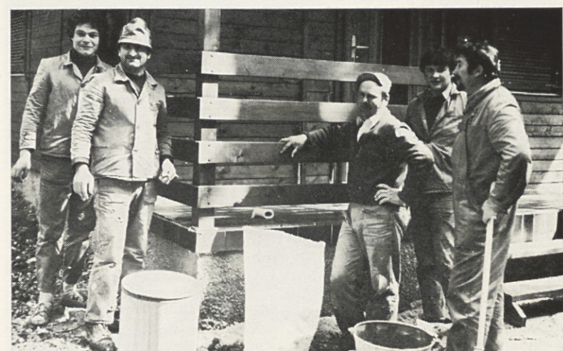
Vzdrževalna dela v počitniškem domu vsako leto dobro opravijo naši vzdrževalci. Pri hišicah Jelovica so letošnje leto pred vhodi namestili ploščice in nove stopnice
