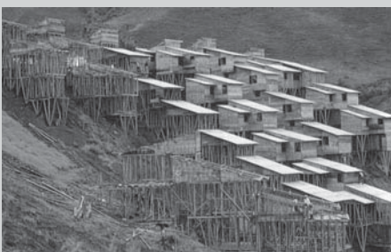
□ Slika 8. Stanovanjsko naselje, Manizales, Colombia, arh. Arcilo Lozada. Naselje, v celoti zgrajeno iz lokalnega gradiva – bambusa - ima socialno in kulturološko vrednost. Vir: Minke, 1983.
