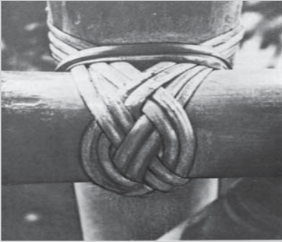
□ Slika 2. Detajl tradicionalne vezave dveh bambusovih palic. Vir: Dunkelberg, 1985.
