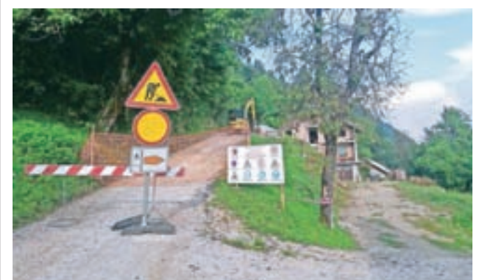
Popolno zaporo ceste zaradi sanacije usada morajo upoštevati tudi pohodniki na Sveti Primož, ki so preusmerjeni na kratko nadomestno pot. / FOTO: JASNA PALADIN
