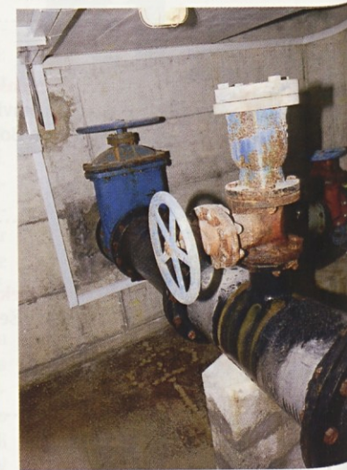
Izbrpano vodo iz Hrastja po ogrmih ceveh črpajo na klorimico, ki je na sosednjem griču.
