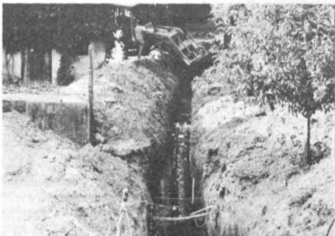
Dela pri izgradnji toplovoda so v polnem zamahu, saj naj bi že konec prihodnjega meseca priključili nanj bolnišnico, nato gospodinjstva
