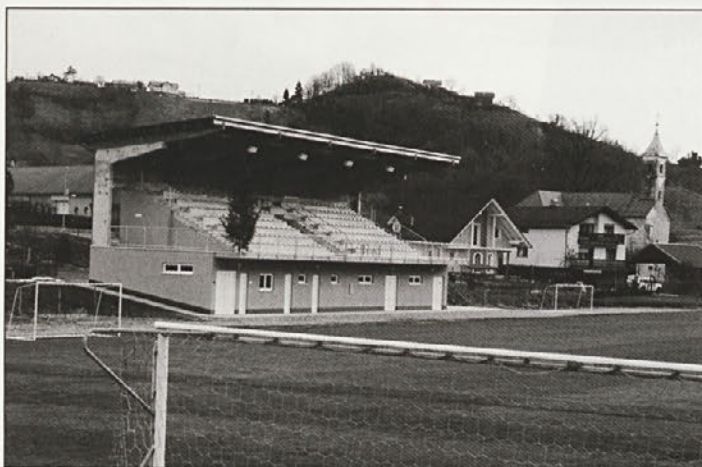
Novozgrajeni športni objekt s slačilnicami v Športnem parku Cirkulane že ima uporabno dovoljenje.
