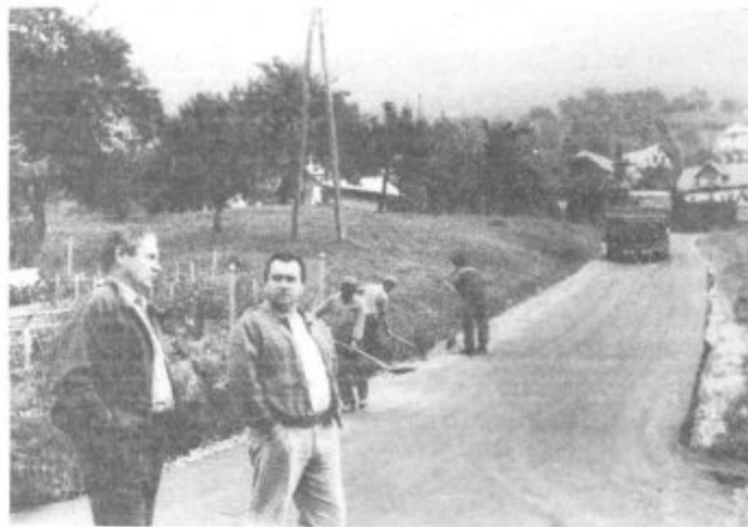
Obnova ceste Hrastovec—Cirkovce. Dela izvaja Cestno podjetje Celje, s katerim velenjska Cestna skupnost dobro sodeluje.
