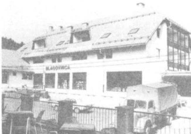
Nov poslovno-stanovanjski objekt v Gornjem gradu
