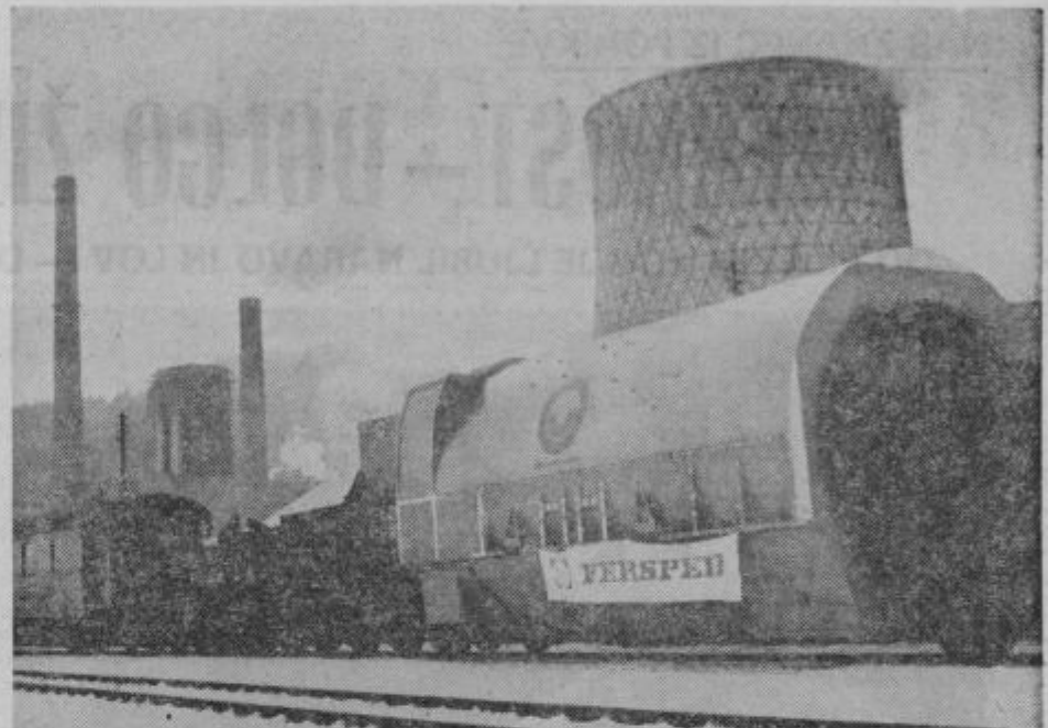
Srce za bodočo TE IV., ki jo gradijo v Soštanju, je že na mestu. Generator, ki je težak 218 ton, so pripeljali v ponedeljek z vlakom. Sam prevoz je bil izredno zahteven, saj je recimo vlak odpeljal iz Celja ob 8.40, v Soštanj pa je pripeljal minuto čez 13. Širina tovara je bila 3950 in višina 4280 millimetrov, tako da so imeli veliko težav tudi pri prevozu skozi tunele, ki jih na relaciji od Maribora do Soštanjja ni malo. Za prevoz so uporabili poseben vagon. Če tega ne bi imeli, bi morali progo ponižati za 17 centimetrov. Prevoz je opravila mariborska poslovalnica Feršpeda, ki je s tem dosegla pomembno delovno zmago. Srce bodočee termoelektrarne IV je tako na mestu in zdaj se ni več bati, da koncem letošnjega leta ne bi začeli dobivati iz tega giganta prve energije, ki jo tako potrebujemo. Foto: LOJZE OJSTERSEK
