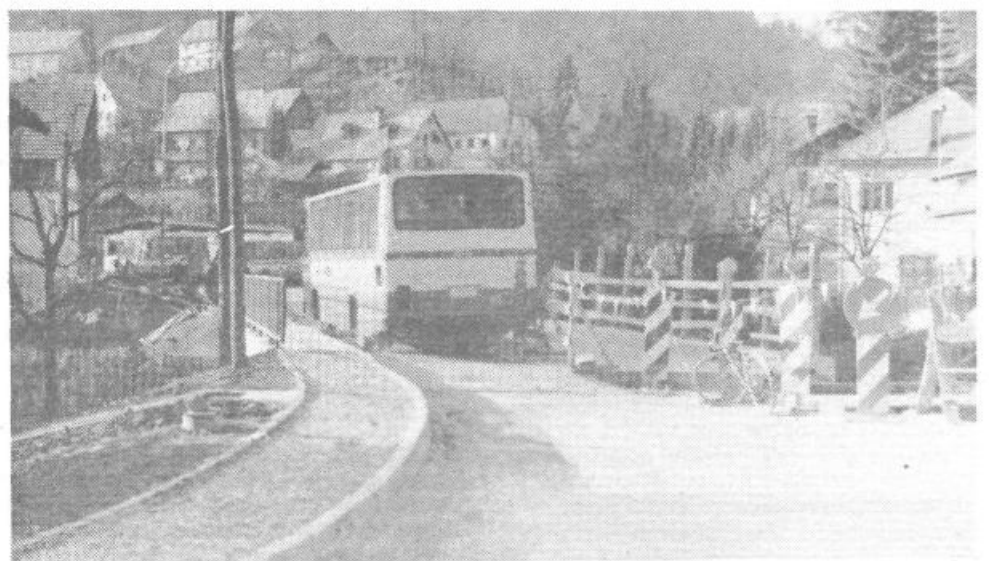
Dela pri obnovi mostu čez Božno so že v polnem teku.
