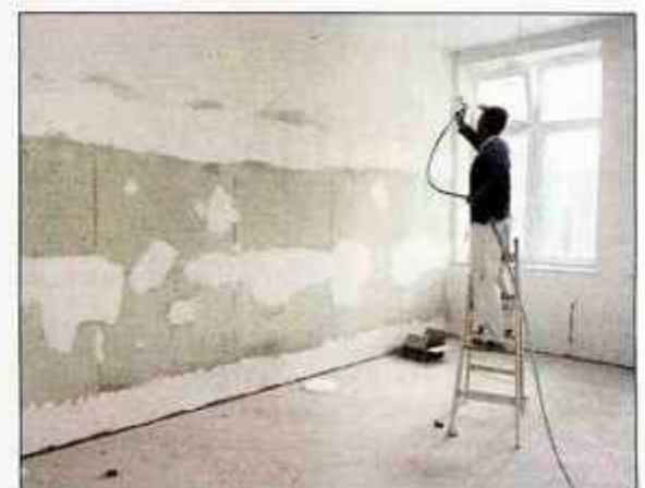
Obnovo starega dela OŠ Šenčur bodo po napovedih zaključili pravočasno. / Foto: Goran Kavčič
