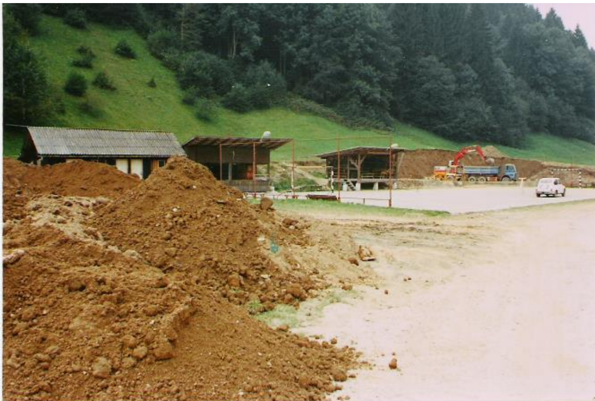
Izkop zemlje za tenis igrišče 1989
