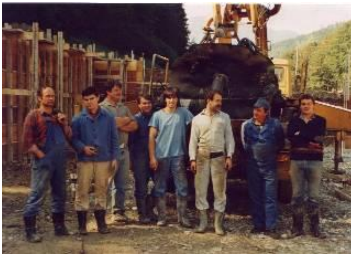
Akcija: izdelava betonskega opornega zidu 1989
