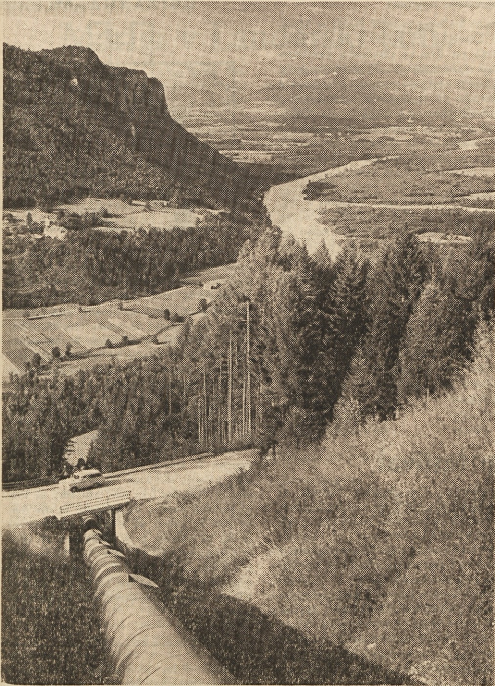
Druckrohrleitung des Kraftwerkes Freibach mit dem Jauntal
