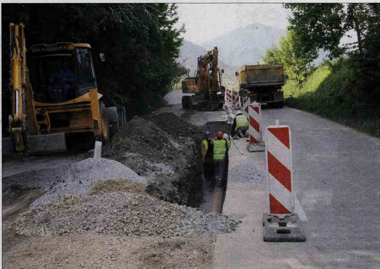
Zaradi gradnje kolektorja je občasno oviran promet na cesti med Žalcem in Grižami.
