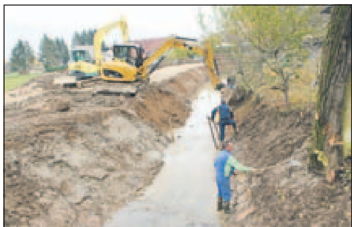
Srednji del struge so izvajalci razširili in poglobili ter ga uredili z večjimi skalami.
