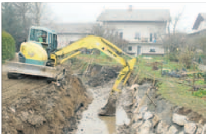
Del struge ob naselju bo urenjen v betonskem načinu.
