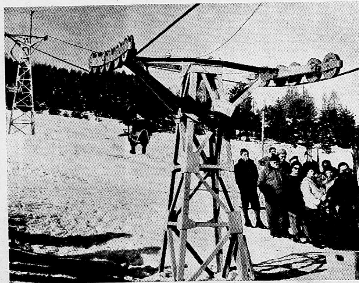
POMEMBNA PRIDOBITEV ZA ZIMSKI SPORT IN TURIZEM NASPLOH JE NEDVOMNO ZICNICA NA VITRANC, KI JO BODO NA PRAZNIK 29. NOVEMBRA SLOVENO IZROČILI NAMENU. — ZDAJ SLUŽI TA NAPRAVA V GLAVNEM PREVOZU GRADBENEGA MATERIALA K SREDNJI POSTAJI, KJER GRADNJO LIGNO OKREPEVALNICO IZ MONFIZNIH ELEMENTOV. NAJBOLJ NEBUDČAKANA MLADINA IZ KRANJSKE GORE IN OKOLICE PA SE ŽE NEKAJ ČASA HADA POSELUJEJE ZICNICA, NA VRHU JE NAMRUC ŽE OKROG 25-CM SNEGA. Foto: Crmak
