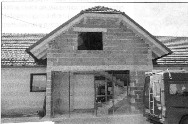
Dela na rekonstrukciji občinske stavbe na Rečici ob Savinji so v polnem teku (foto: Marija Lebar)
