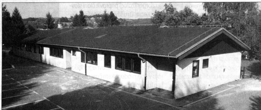
Mobilna enota s štirimi kontejnerji bo postavljena na zahodni strani obstoječe zgradbe vrta (foto: Benjamin Kanjir)
