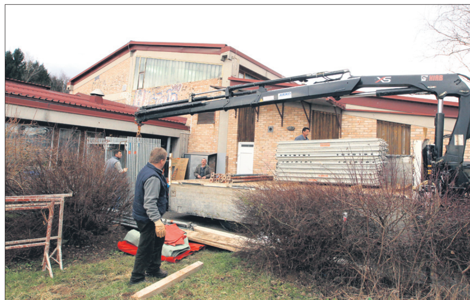
Gradbeni delavci so se v petek dopoldne lotili popravilnih del in s strokovnjaki pregledali ostale prostore v šoli, in sicer zaradi nevarnosti, da bi se stropi dalje sesedali. (Foto: SHERPA)
