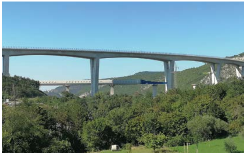
Slika 3: Viadukt novega tira Koper–Divača pri Črnem Kalu teče pod avtocestnim viaduktom primorske avtoceste (foto: Andrej Jakobčič, Wikimedia Commons).
