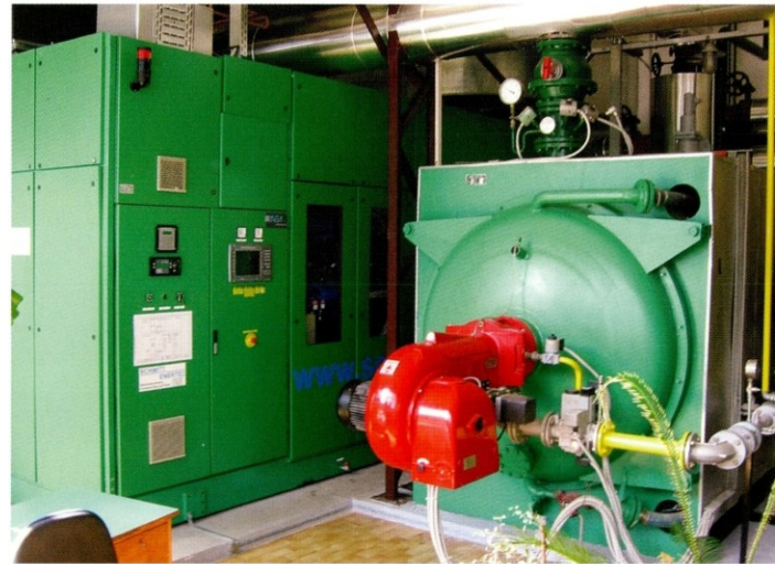
Namesto obstoječega plinskega kotla bodo postavili dodatni modul SPTe
