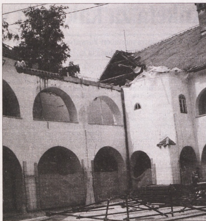
"OBGLAVLJENI" GRAD - Po nekoliko daljših pripravah so na metliškem gradu le začeli popravljati dodobra dotrajano ostrežje. Ker je preveliko, da bi ga zamenjali v enem zamahu, dela potekajo postopoma. Tako so pretekli teden najprej odkrili del gradu nad poročno dvorano in grajsko točilnico (na fotografiji). Preden bodo postavili novo ostrežje, bodo zamenjali tudi strop v prvem nadstropju gradu. (Foto: M. B.-J.)
