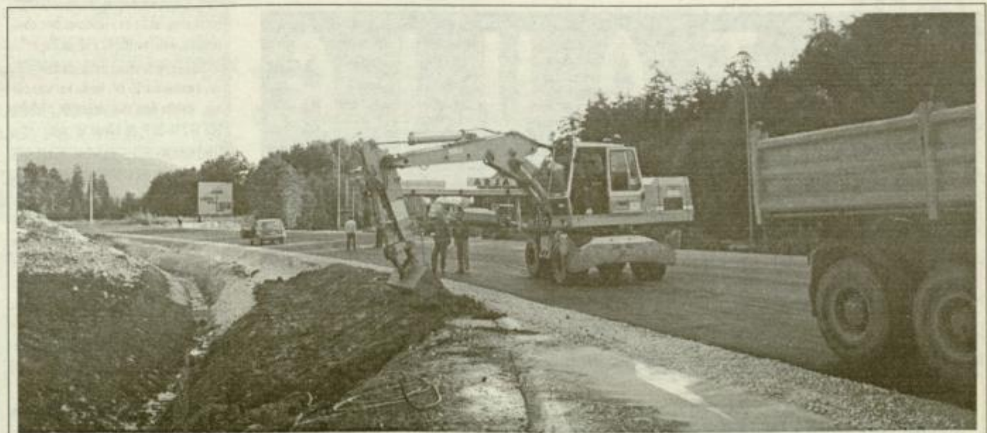
V Arji vasi pospešeno gradijo priključek na velenjsko cesto, dela bodo zaključena v nekaj dneh, do konca leta pa bodo po zagotovilih Darsa podrti tudi objekti na stari cestninski postaji v Arji vasi, prav tako pa tudi vse ostale stare cestninske postaje ob avtocesti.
