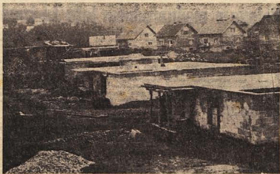
AVTOMEHANIČNA DELAVNICA NAPREDUJE. Na Pionirjevem gradbišču v Metliki je precej živahno. Lepo vreme je omogočilo začetek gradnje nove avtomehanične delavnice, na katero vozniki motornih vozil iz vse Bele krajine že komaj čakajo. (Foto: Ria Bačar)
