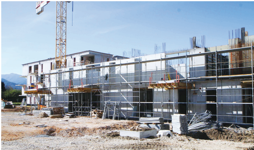
Gradnja dveh blokov – 60 stanovanj
