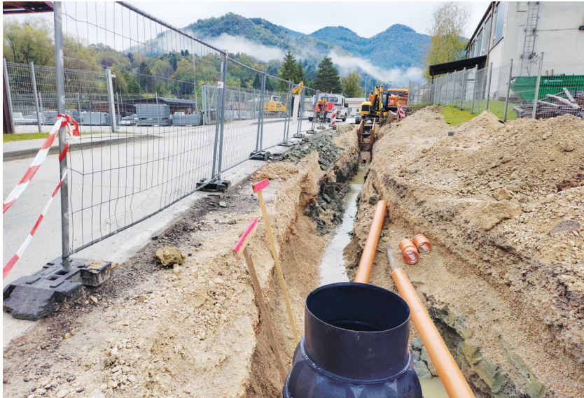
Trenutno poteka izgradnja kanalizacije ob cesti proti kamnolomu.
