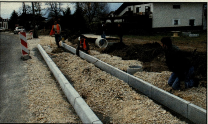
Pri gradnji pločnika so položili tudi cevi za padavinsko vodo
