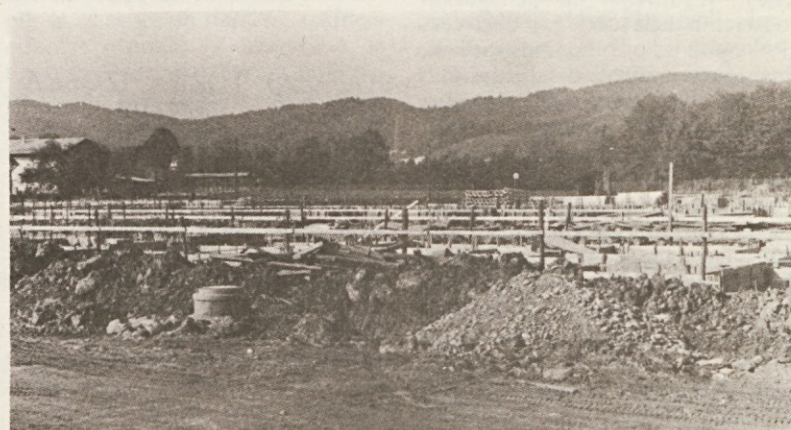
Gradnja se je začela. Obrisi temeljev bodočih hiš. (Foto: M. M.)
