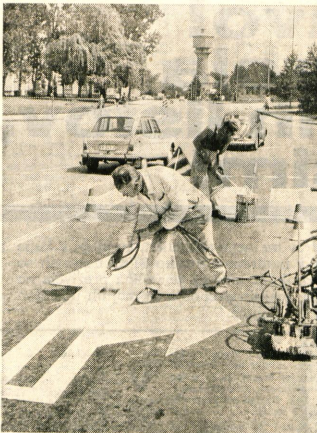
Pred kratkim so v Kranju začeli z obnavljanjem oznak na cestišču in prehodih za pešce. Letos ta dela namesto Komunalnega podjetja opravlja Cestno podjetje Kranj. — Foto: F. Perdan
