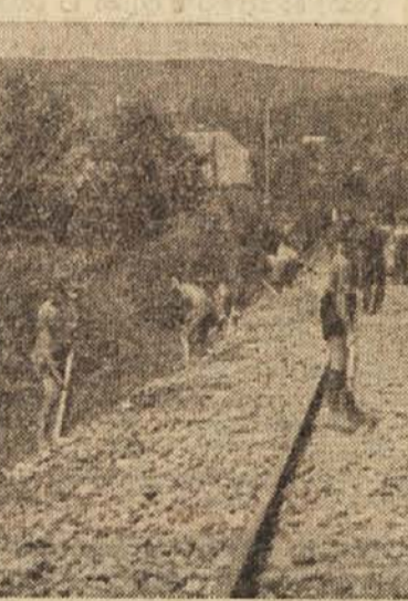
Železničarjem so priskočile na pomoč pri obnovi naših prog tudi mladinske delovne brigade. Na sliki gradnja proge v Beli krajini
