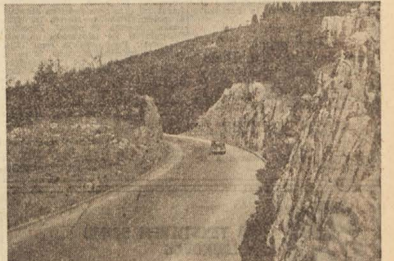
Eno izmed najlepših cestno gradbenih del je odsek zvezne ceste I/10 od Vrhnike do Logatec. Pogled na usk pri Sncžnem griču
