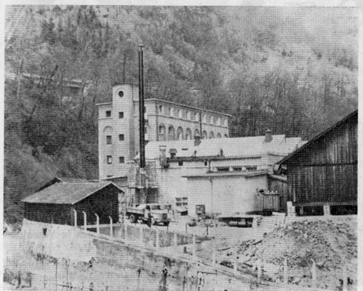
Gradbena dela na kotlovnici za ogrevanje tehnološkega olja za potrebe razpenjalnega sušilnika hitro napredujejo
